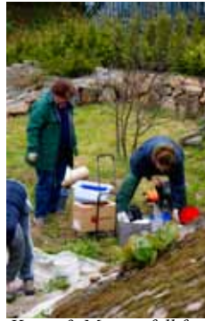
Karin & Maria i full fart med betonggjutning
